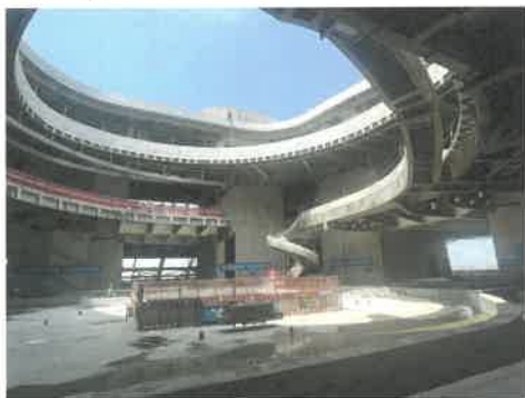
建設中の深圳深海博物館(2025年4月) 2階3000㎡の絲綢之路コーナーに当館の 収蔵品を展示予定。
